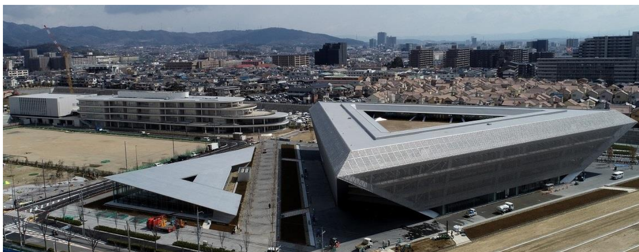
上空(南西)から見た総持寺キャンパス(左奥:中・高棟 中央:食堂 右手前:大学棟)
