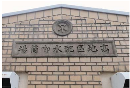
図5 高地配水唧筒(ポンプ)場
