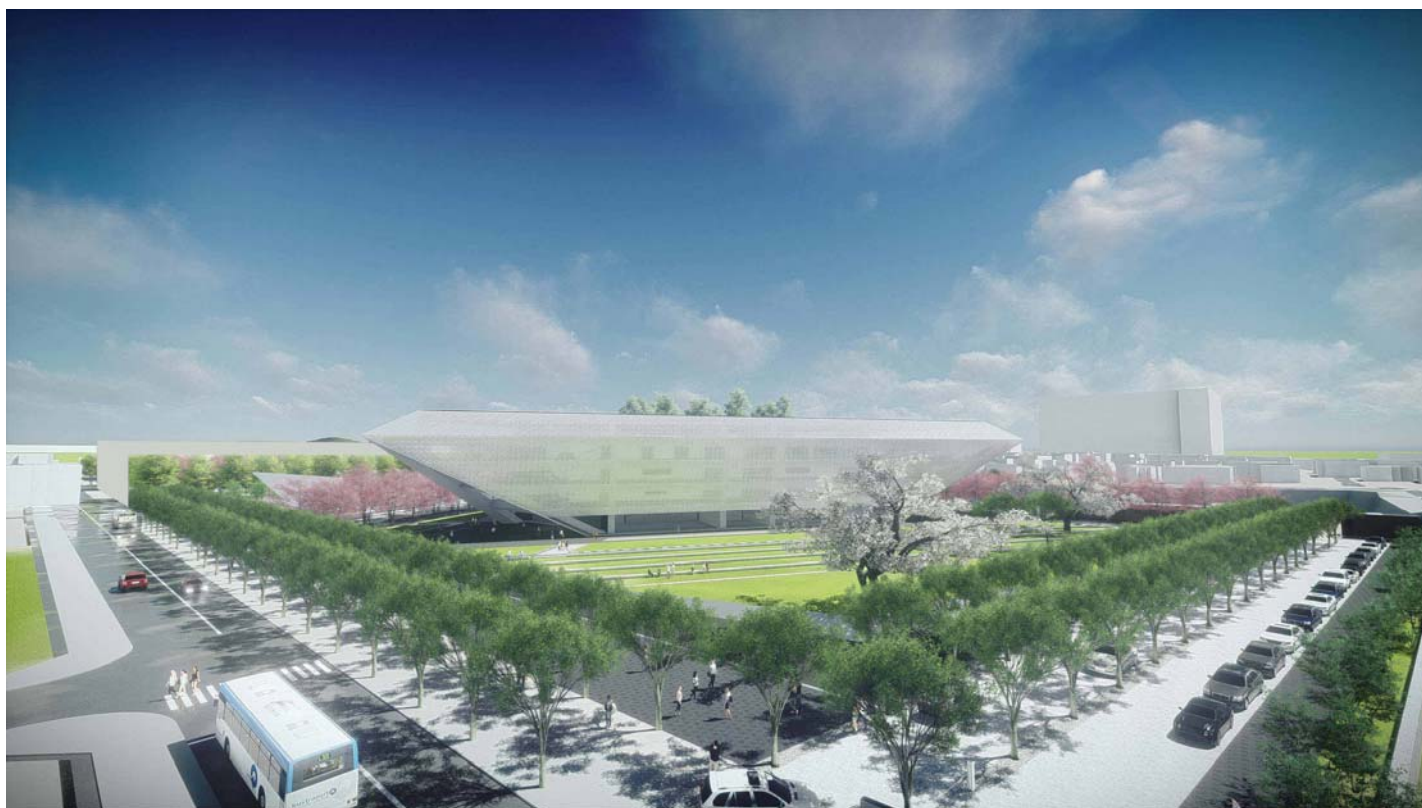
南(総持寺駅)側の横から見た大学校舎のイメージ
